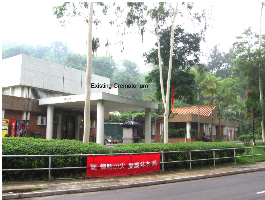
Photo 5 VSR5 – View from Kiu Tau Road
